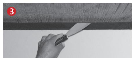
Continúe a lo largo de la junta comprimiendo la espuma Blaze Foam y empujándola en el área de la junta. Para facilitar la instalación, se puede usar un cuchillo para masilla o una llana para comprimir la espuma Blaze Foam y deslizarla en su lugar.
