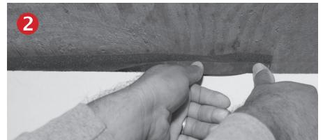
Sujetando la espuma Blaze Foam con la tira intumesciente hacia abajo, comprima la espuma de forma que pueda colocarse dentro de la junta entre la parte superior de la pared de yeso y la parte inferior del piso de hormigón de arriba.
