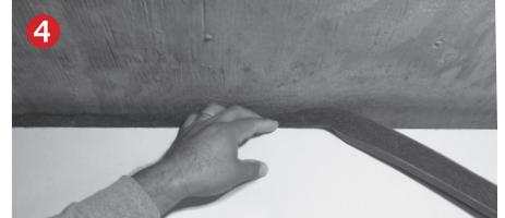
La espuma Blaze Foam se puede instalar a ras con el plano exterior de la pared o empotrada contra el carril de rodadura superior. Asegúrese de que la tira intumesciente quede plana sobre el borde superior de la pared de yeso.
